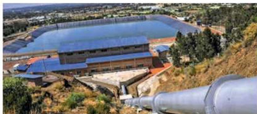
La planta hidroeléctrica del Complejo Múltiple Misicuni, en Cochabamba. TUNEL JAMES
